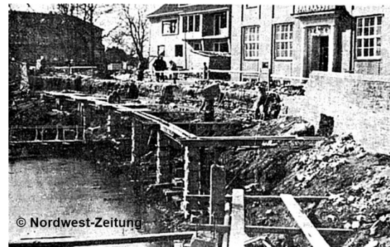
Arbeiten an der Albanstraße, 12.03.1959, Nordwest-Zeitung, Bild: Stehr
